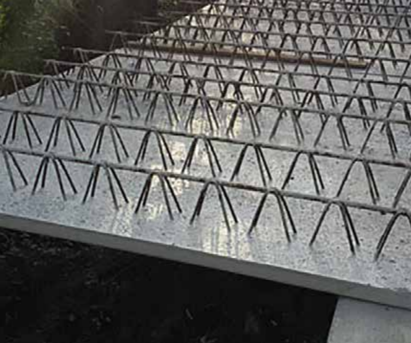
AMPLIAMENTO SEDE STRADALE Adeguamento SP 163 tra Borgo Fornari e Voltaggio. Produzione di lastre a sbalzo ancorate a micropali per ampliamento sede stradale.
